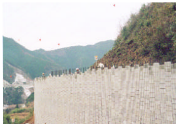
写真-5 組立自立外壁パネル工法施工状況
