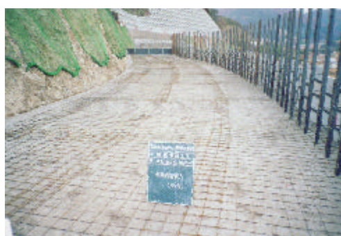
写真 - 10 鉄筋金網の設置状況
