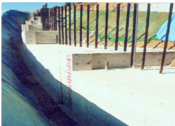
写真 - 7 台座コンクリート施工状況
