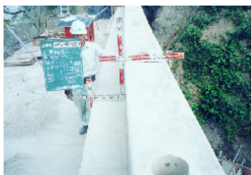
写真 - 11 笠コンクリート施工状況
