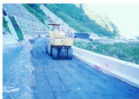
写真 - 12 路体・路床盛土施工状況
