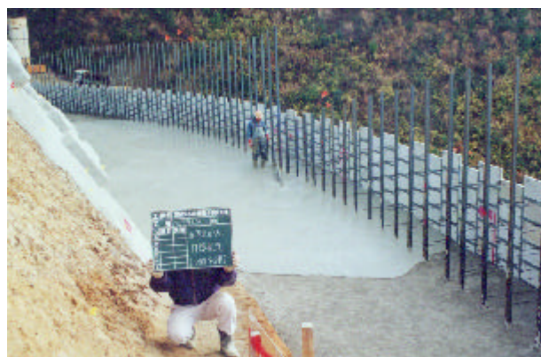
写真-4 気泡混合土打設状況
