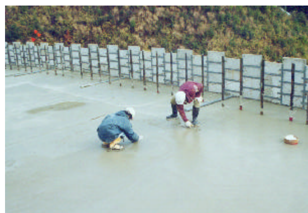
写真 - 8 防水対策状況 (張りコンクリート)
