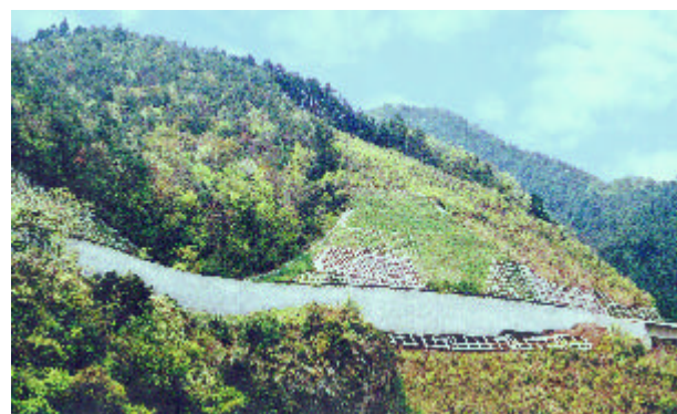
写真 - 1 完成した湖岸道路
