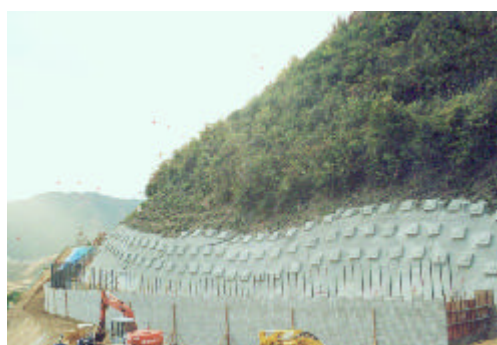
写真 - 9 床掘背面の地山補強状況
