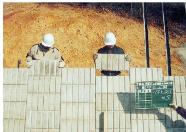
写真 - 6 外壁パネル組立状況
