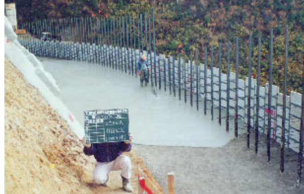
写真 - 2 気泡混合土打設状況
