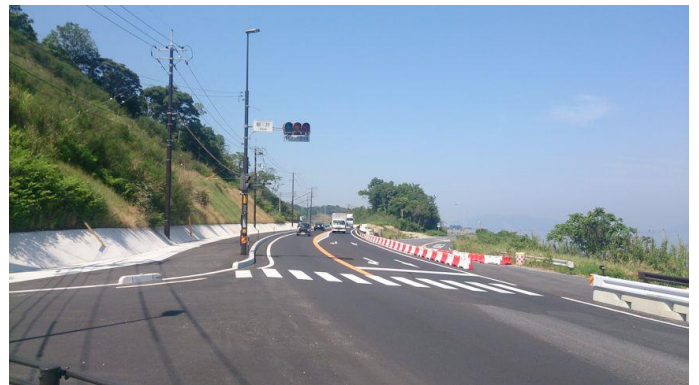
写真-2 起点側完成写真
